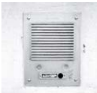
Gennemtestet og anvendt i årtier, men i dag i mange tilfælde klar til udskiftning: Siedle-anlæg fra serien TL 111.
